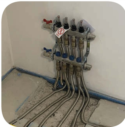
Anwendungsbilder einer Verlegung mit dem FloorFlex System
